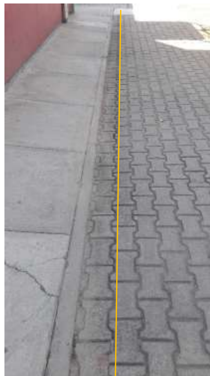
Evidencia de posibles hundimientos, Edificio Q (imagen capturada el 02/dic/16)
