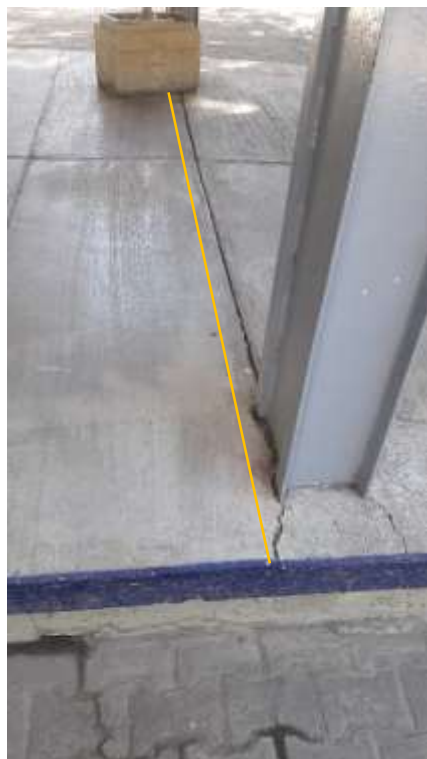
Fisuras en puente entre edificios P y Q, (Imagen del día 2/dic/16)
