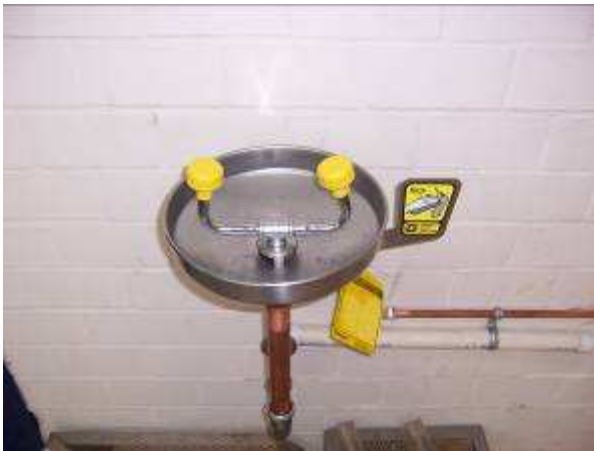
Instalación de lava-ojos en laboratorios
